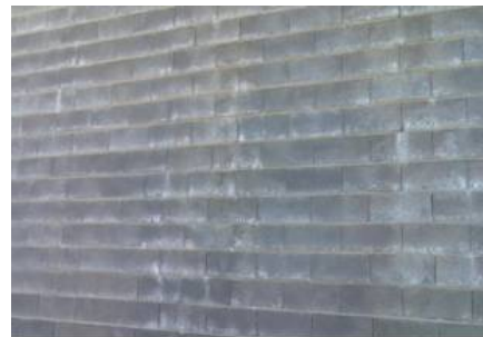
Fig.3. Eflorescencias en MCP primarias (arriba a la derecha) y secundarias (las restantes). La falta de hidratación del cemento y las sales solubles libres existentes en masa afloran a la superficie por arrastre del agua absorbida. Las sales se carbonatan posteriormente con el CO 2 ambiental generando depósitos salinos.
