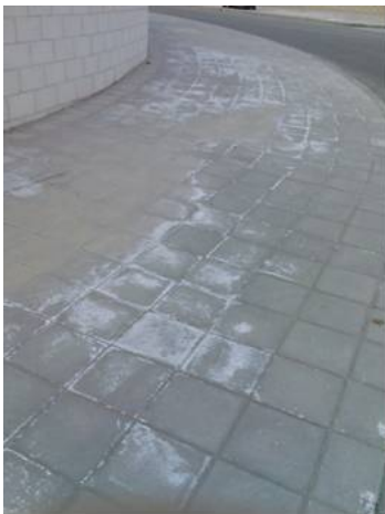
Fig.3. Eflorescencias en MCP primarias (arriba a la derecha) y secundarias (las restantes). La falta de hidratación del cemento y las sales solubles libres existentes en masa afloran a la superficie por arrastre del agua absorbida. Las sales se carbonatan posteriormente con el CO 2 ambiental generando depósitos salinos.
