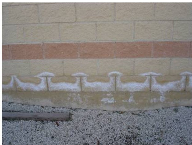
Fig.1 Generación de eflorescencias primarias en el acopio (izquierda) y secundarias (derecha).
